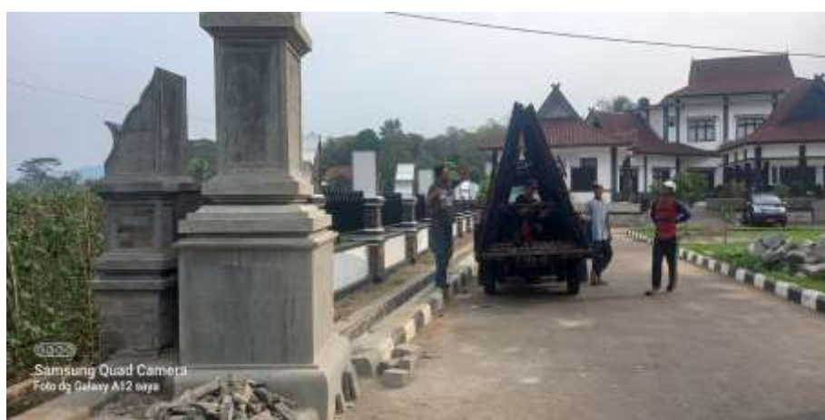
Pembangunan gedung Kecamatan Tegalwaru Kab. Purwakarta
