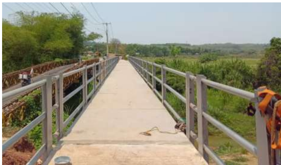
Jembatan Jatimulya Kec Campaka
