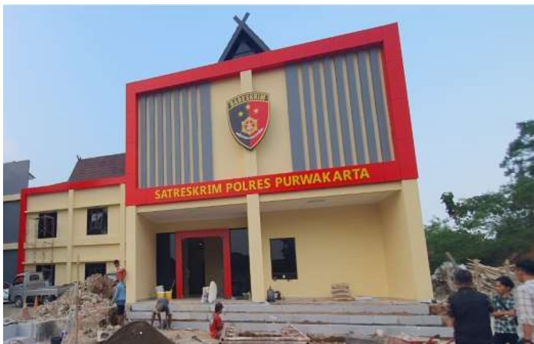
Pembangunan gedung Satreskrim Kab. Purwakarta
