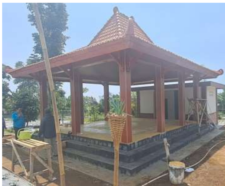
Pembangunan Pendopo Kebun Ambu
