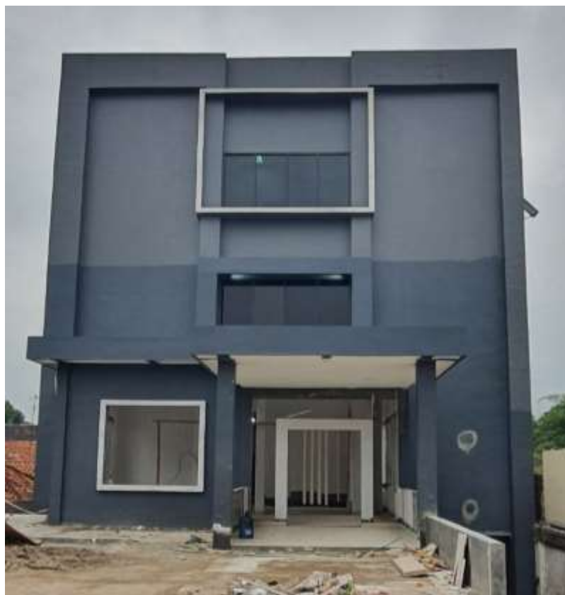
Pembangunan gedung Diskominfo Kab. Purwakarta
